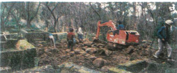
— 工 事 中 の 別 当 基 地 —
